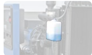
Расширительный бачок системы охлаждения
