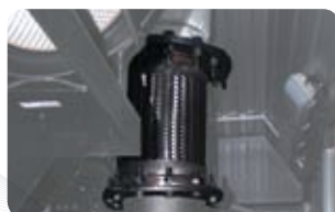
Гибкий переходник выхлопной системы
